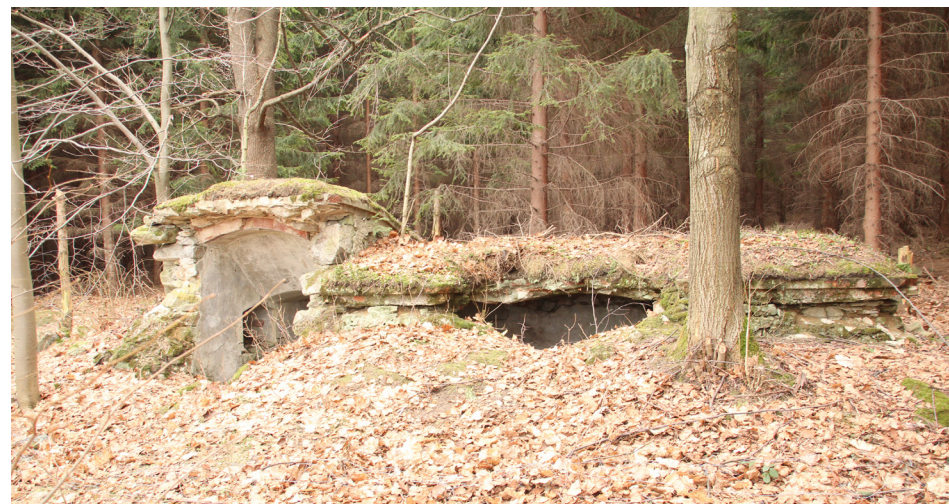
Piwnica piwna. Stan na rok 2013.
