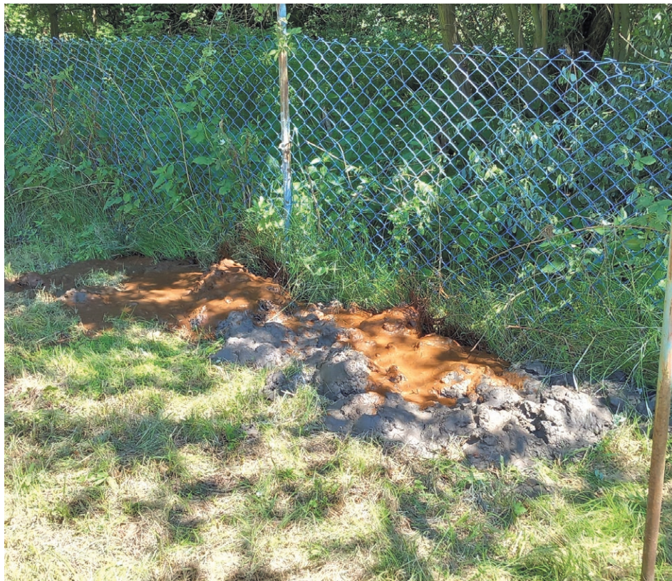
Błoto po oczyszczeniu studni, tzw. namuł
