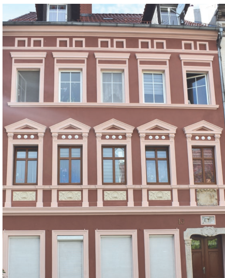
Fot. Kamienica po remoncie
