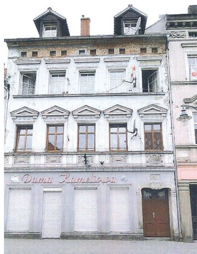
Fot. Kamienica przed remontem
