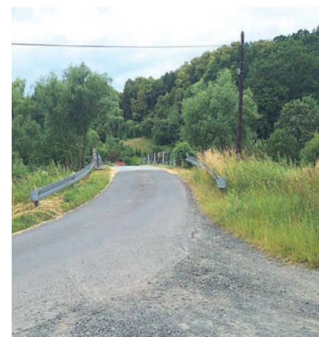
Szyszkowa obecny stan mostu
