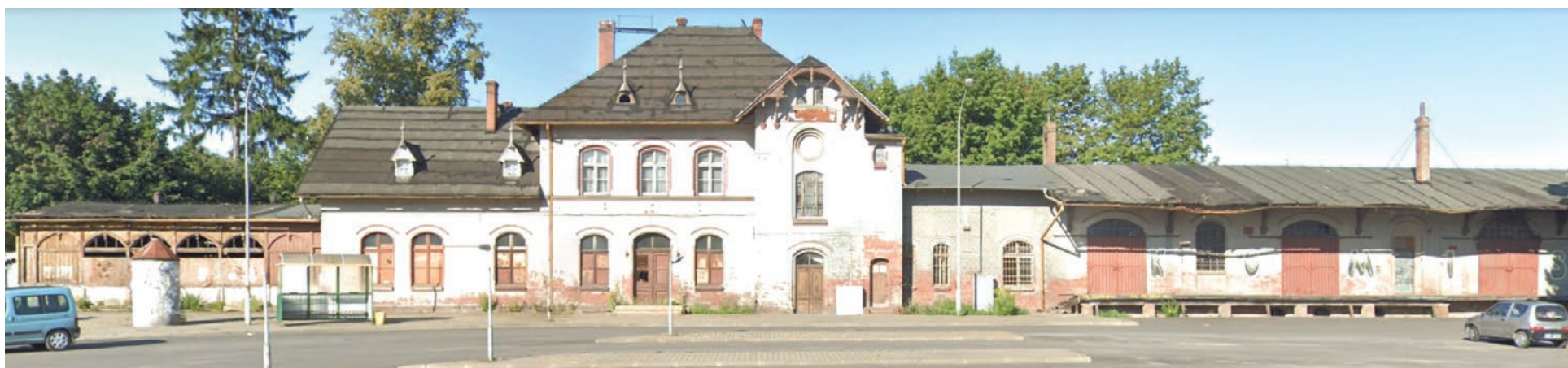
Dworzec PKP przed remontem
