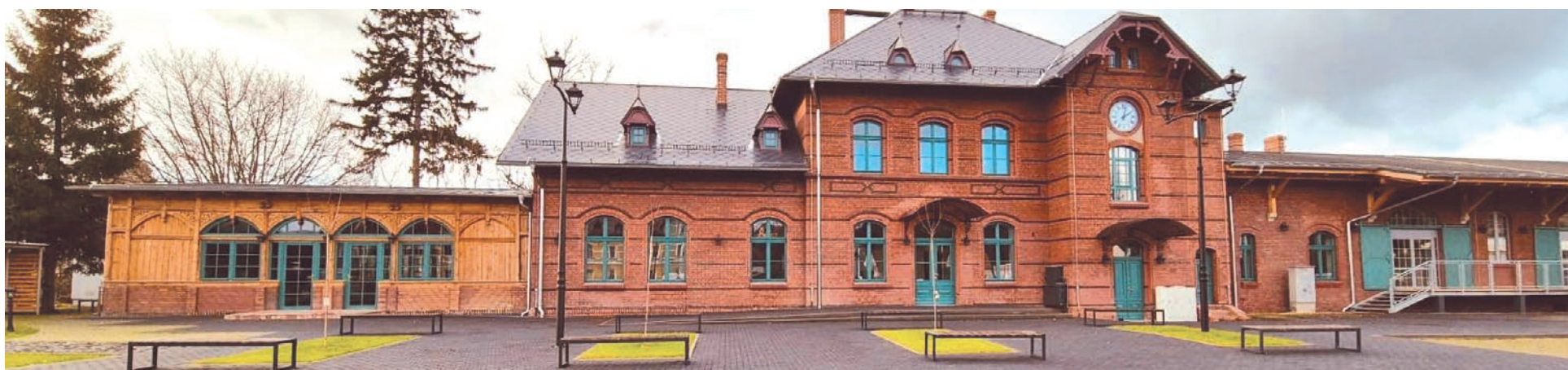
Dworzec PKP po remoncie
