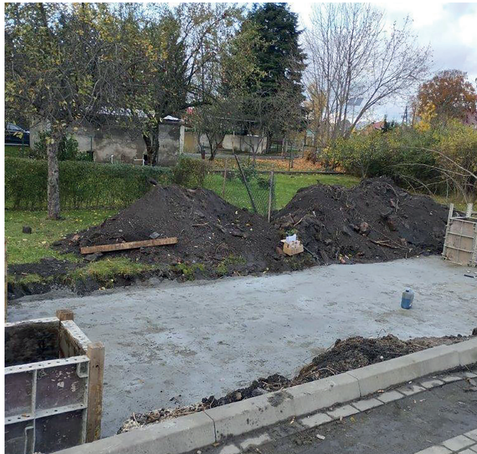
Teren pod boks śmietnikowy przy ul. Ogrodowej
