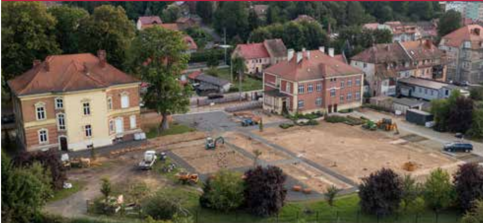
Teren powstającego Izerskiego Centrum Adaptacji do zmian klimatu w Leśnej, będziemy go zwiedzać w trakcie pikniku, fot. M. Dragan
