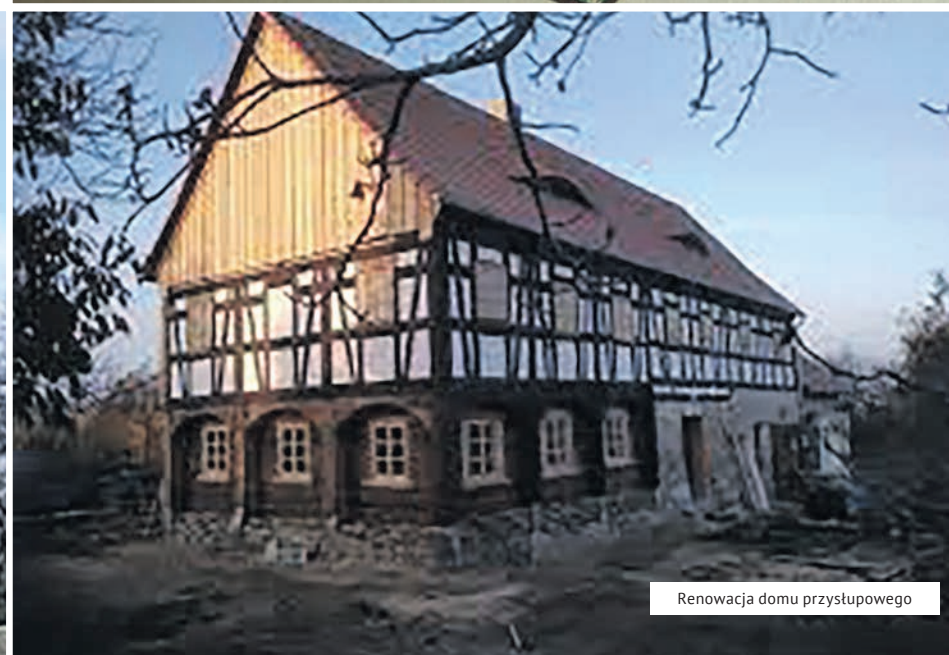
Dom przysłupowy w pełnej krasie
