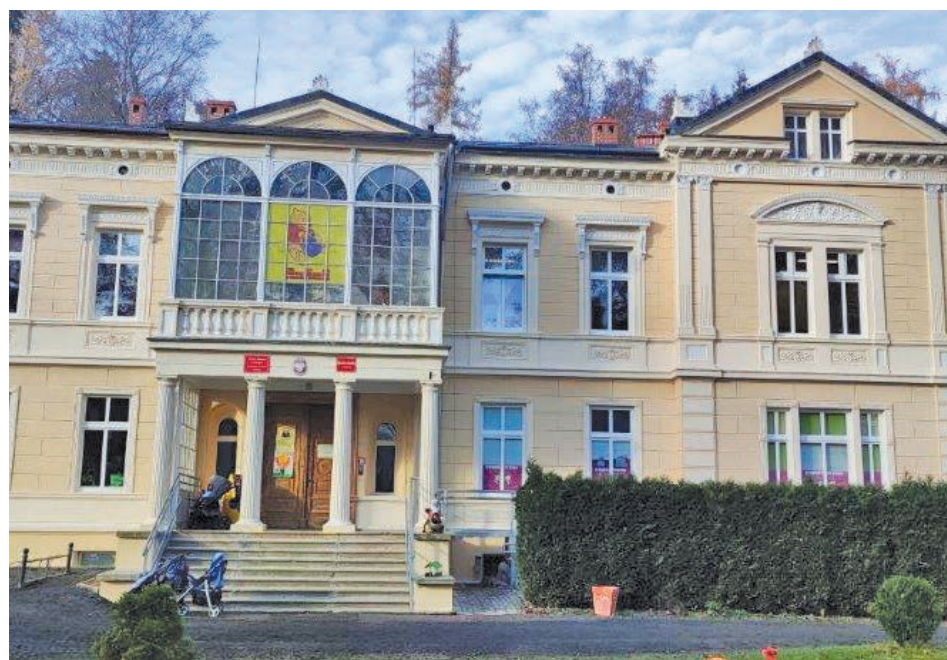
Gminne przedszkole po remoncie
