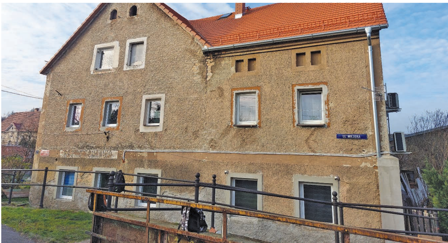
ul. Wiejska 2, Leśna - wymiana pokrycia dachowego.
