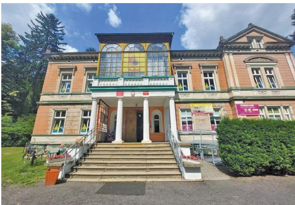
Gminne przedszkole przed remontem
