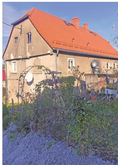
ul. Zaułek 5 po wymianie dachu
