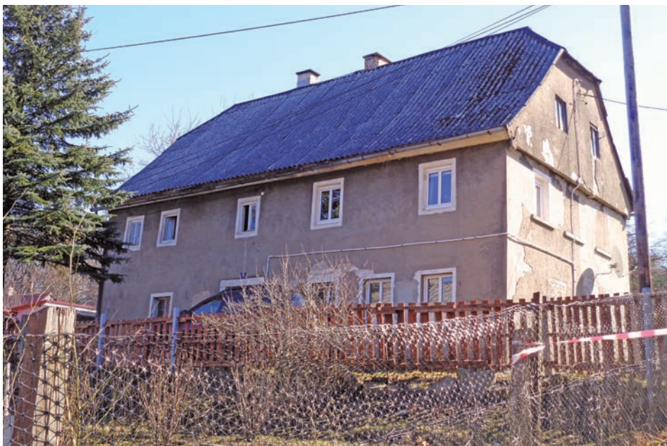
ul. Zaułek 5, Pobiedna - przed remontem (wymiana pokrycia dachowego)
