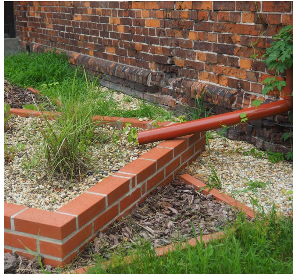
Ogród deszczowy w gruncie. Fot. K. Kopecki, Fundacja Sendzimira
