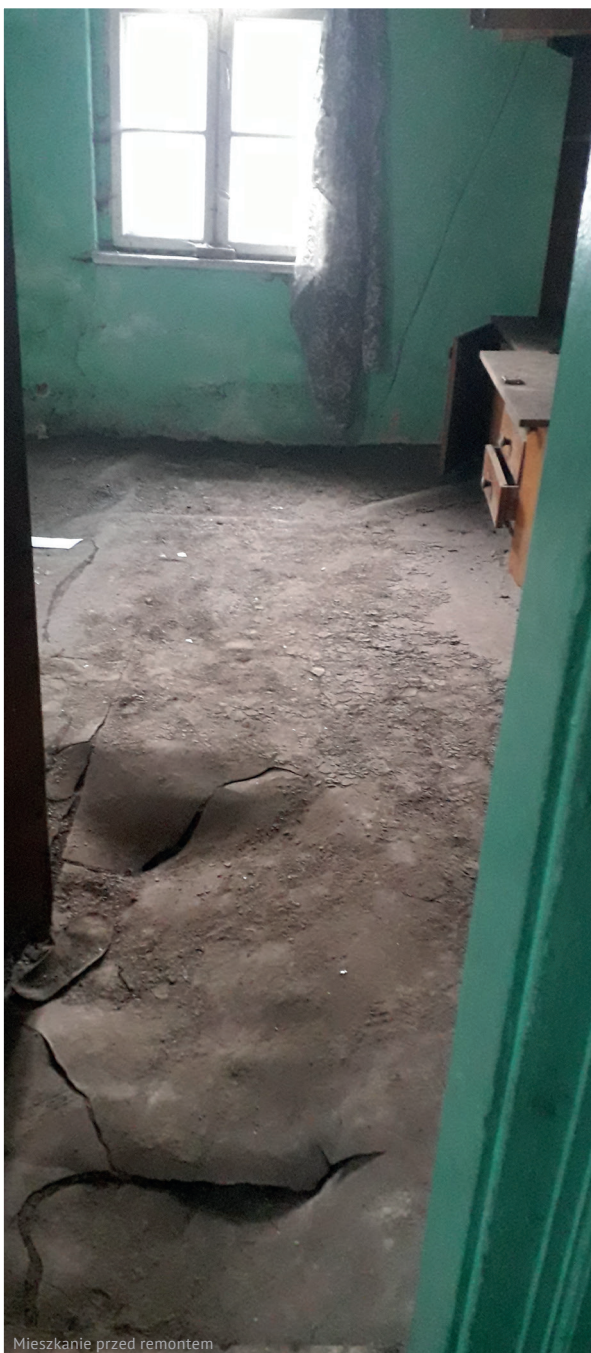
Mieszkanie przed remontem
