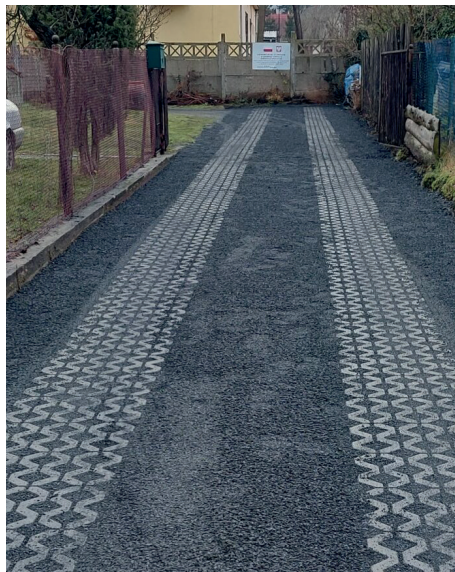
ul. Baworowo w Leśnej, droga do posesji nr 48, 48a, 47, 47a
