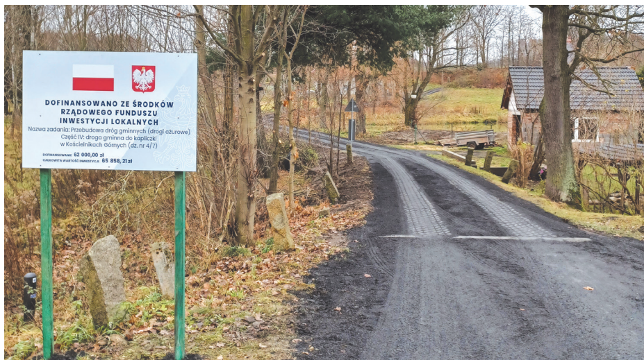
Zdjęcie z drogi wykonanej w Kościelnikach Górnych (do kapliczki)
