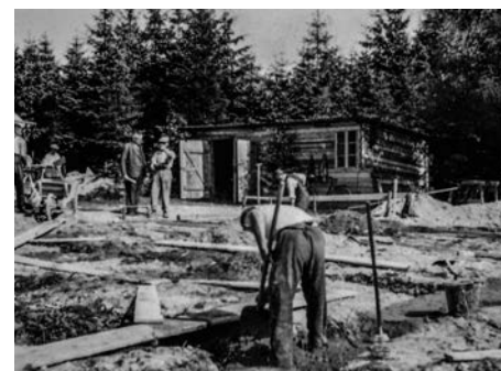
Wylewanie ław fundamentowych pod domek.
