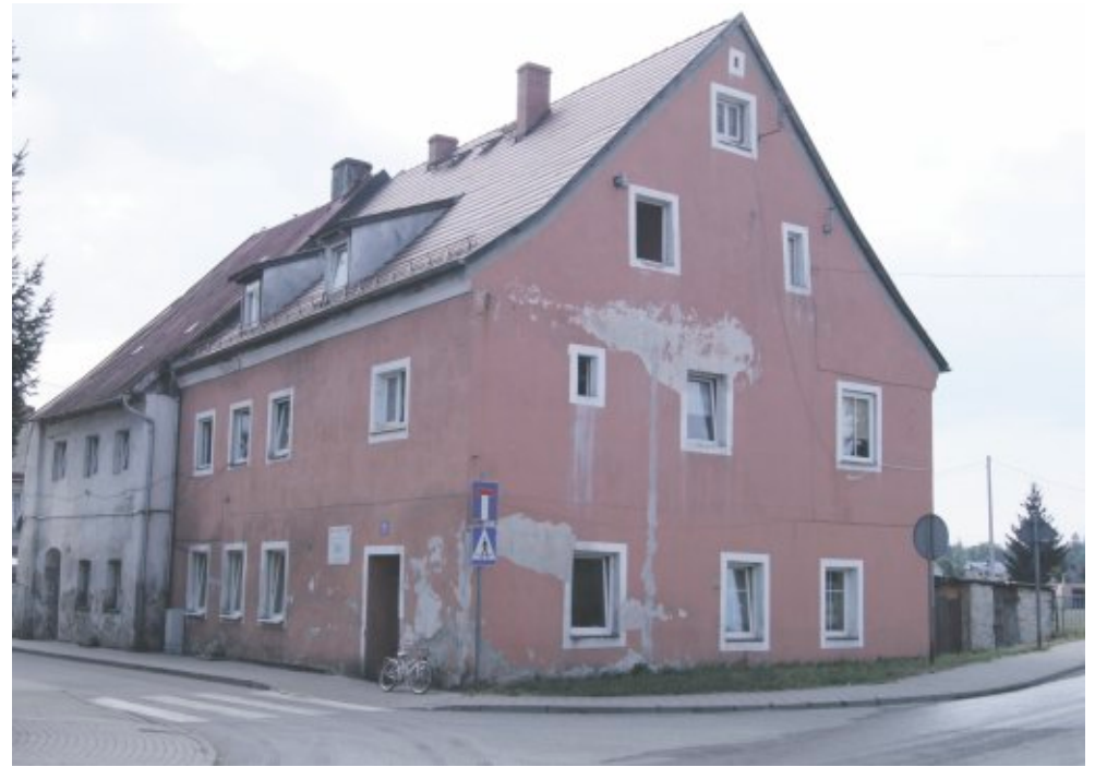
▲ Prezentowany na zdjęciu budynek przy obecnej ulicy Żeromskiego (przed wojną ul. Kirchstrasse) to dom, w którym mieszkali – według ich relacji – Kerndtowie przed wyjazdem do USA.
