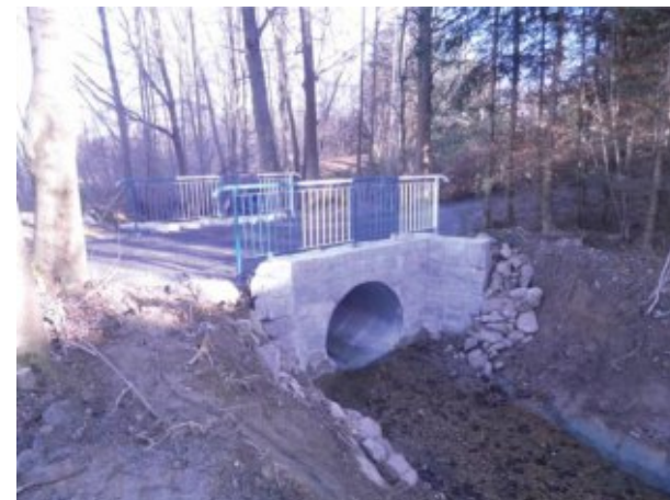
2. Naprawiony przepust w Grabiszczach
